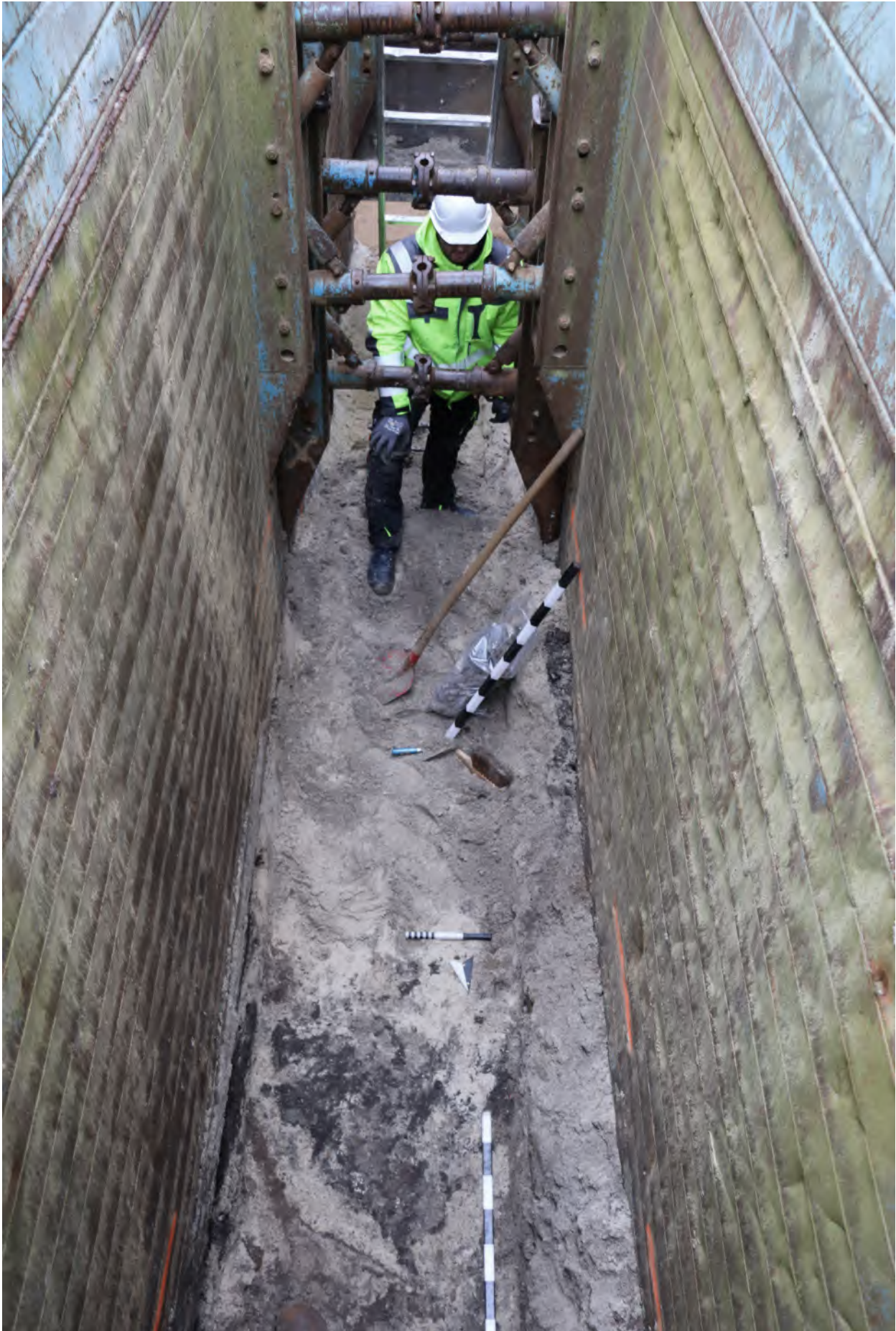
Abb.4 Arbeitssituation im Leitungsraben.
