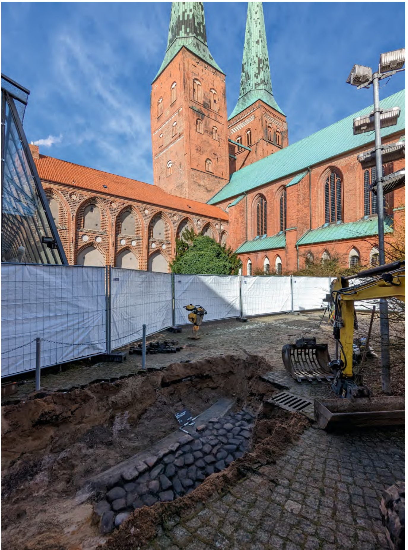
Abb. 4 Fundament des (Treppen-)Turmes und altes Museumshofniveau (Abschnitt 1).
