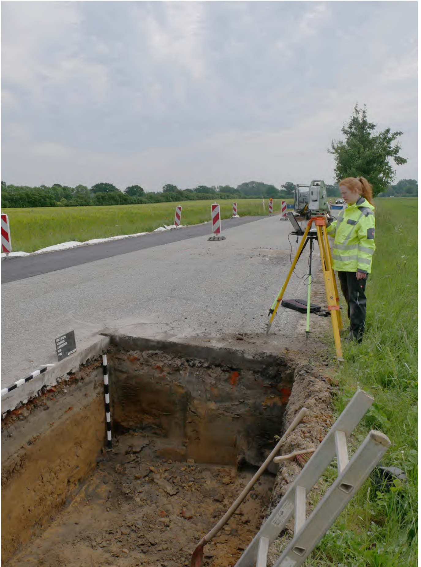
Abb. 2 Vermessungsarbeiten im Straßenbereich.
