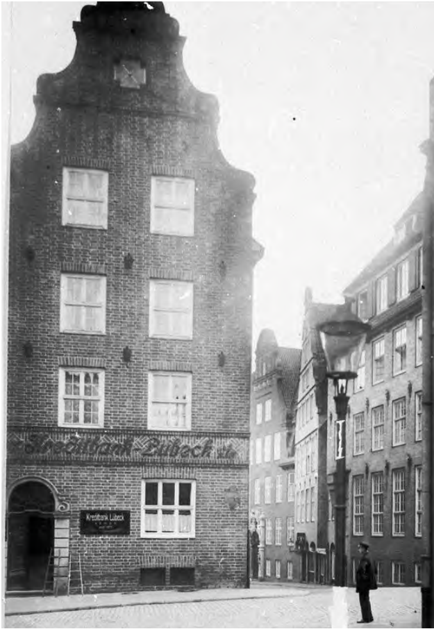
Abb. 6 Historische Aufnahme um 1910: Blick nach Norden in die ehemalige Kreuzung Mengstraße/Schüsselbuden/Fünfhausen. Letzte Bauphase von Mengstraße 18 vor der Kriegszerstörung von 1942 ( https://www.bildindex.de/document/obj30150846? ).
