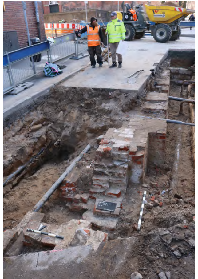
Abb. 7 Zu Fünfhausen gewandte östliche Traufmauer von Mengstraße 18 mit mindestens drei Bauphasen. Die Mauerreste liegen direkt unter dem Asphalt der Straße. Mehrfache Störung durch moderne Versorgungsleitungen.
