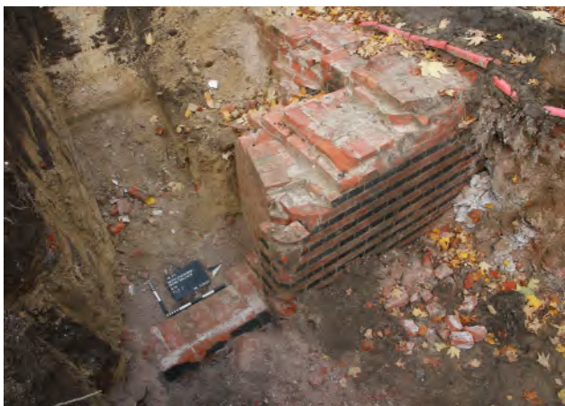
Abb. 3 Ehemalige Ostfassade des alten Museums mit Fensteröffnung (Abschnitt 16).
